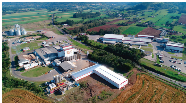
Parque fabril de Encantado e de Arroio do Meio
