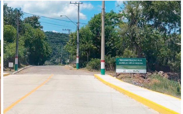
Rua Aurélio Hélio Moesch reconstruída: 90 metros de extensão por 12 de largura, único acesso ao Porto Quinze
