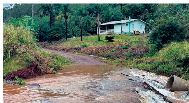
— Iniciada a construção de uma nova ponte de concreto armado na estrada da Linha Parobé, em Roca Sales. A obra vai substituir a atual travessia e melhorar a segurança e o tráfego em uma via estratégica para o escoamento da produção agrícola e ligação com Santa Tereza e a Serra Gaúcha
