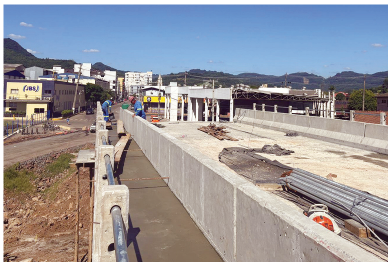
— Construção da ponte no Centro está em estágio avançado
