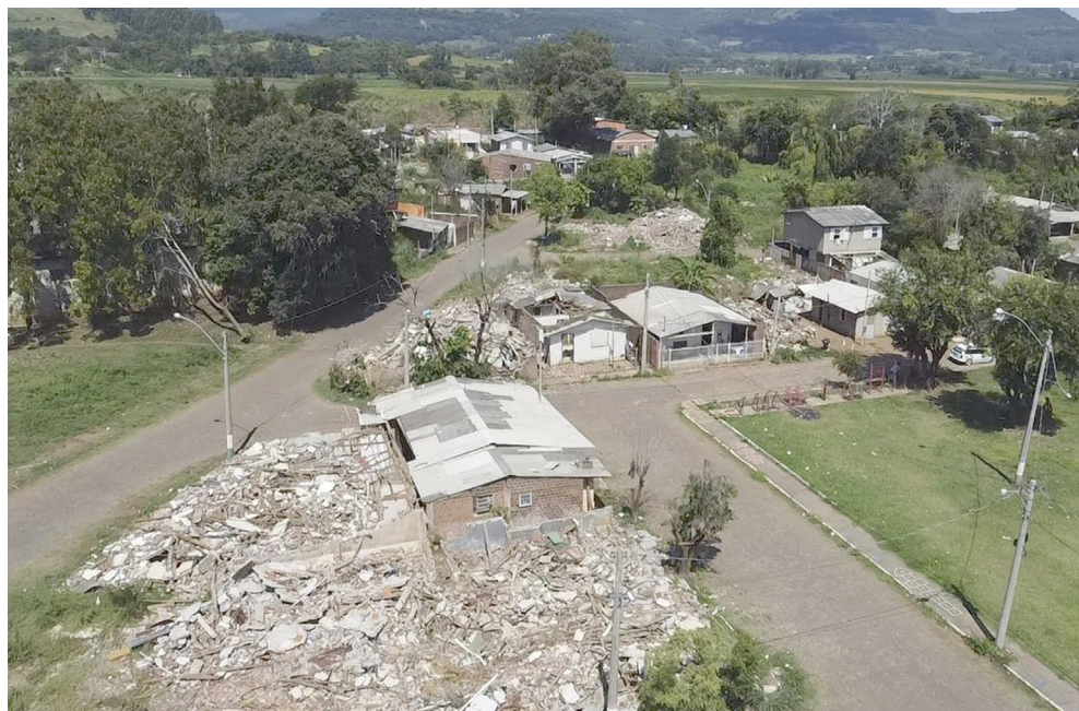
Bairro Navegantes, em Encantado, já tem várias casas desmanchadas
