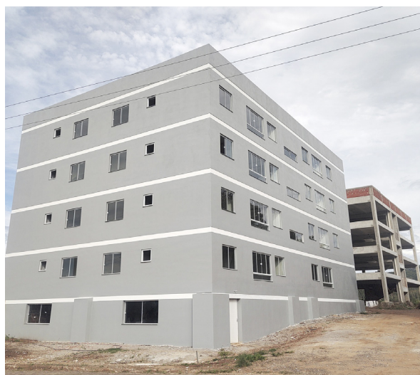
Primeiro bloco está concluído
