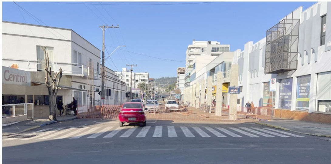
— A rua coberta está sendo construída na Barão do Rio Branco entre a Júlio de Castilhos e Duque de Caxias, quase em frente à Casa de Cultura de Encantado
