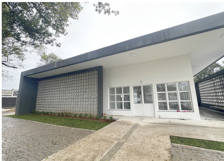
Posto de saúde praticamente concluído, começa a receber mobiliário. Obras da Escola e do CAPS seguem o cronograma
