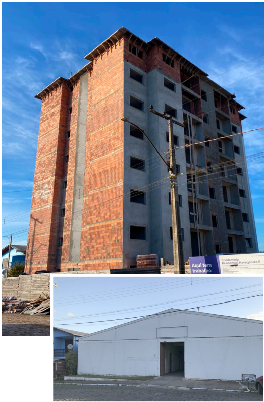
O local do antigo berçário no Bairro Nossa Senhora Aparecida deu lugar a construção de apartamentos que vai abrigar cidadãos que perderam tudo nas enchentes
